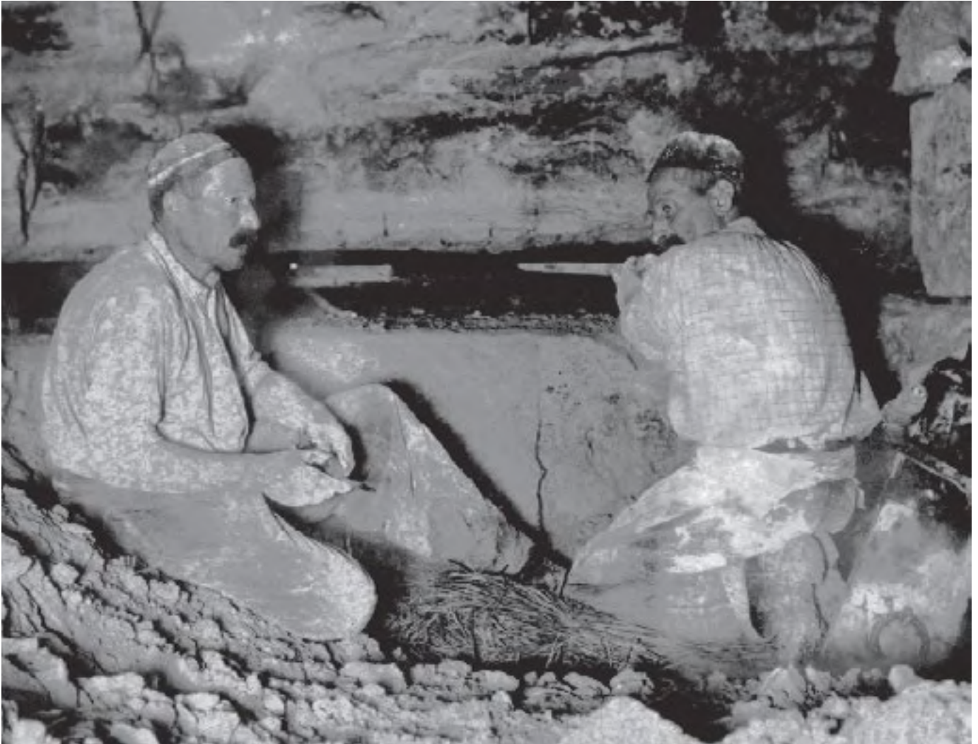
Carriers exploitant les calcaires du Lutétien dans une carrière souterraine à Bagneux en 1906. Photo Vallet © IGC
