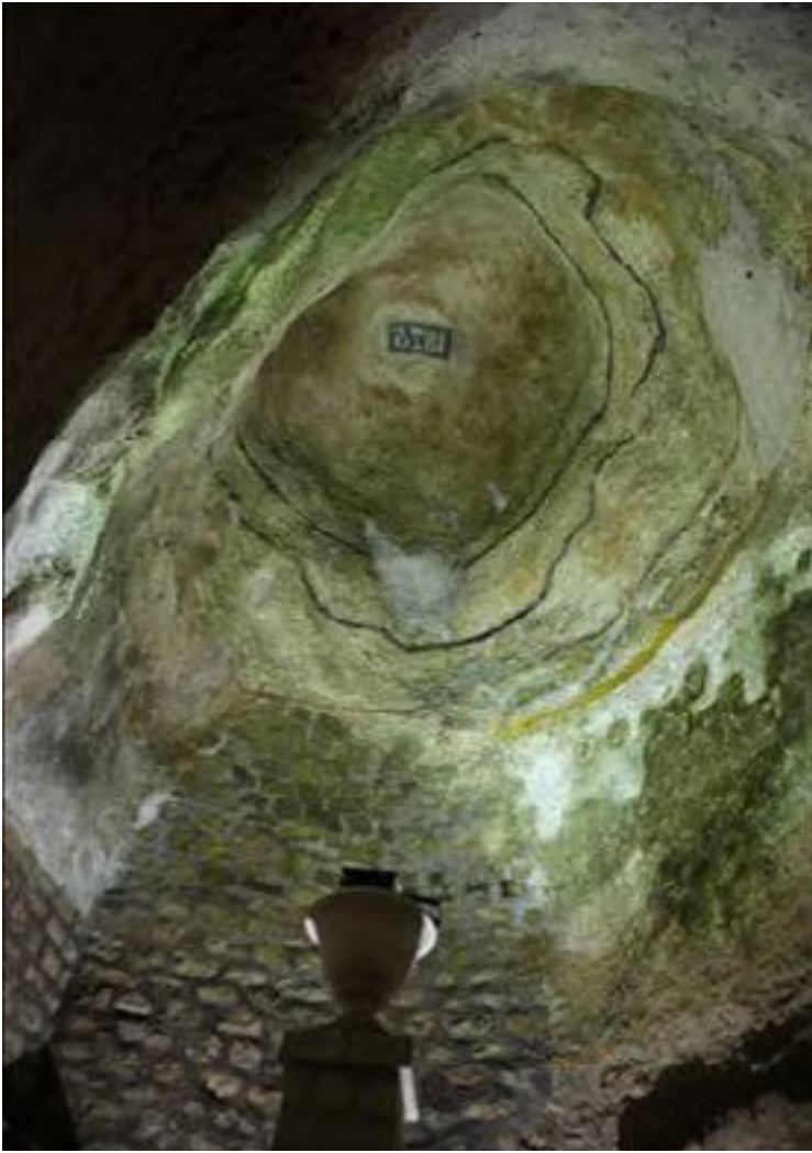
Catacombes de Paris : galerie de sortie, cloche de fontis.
